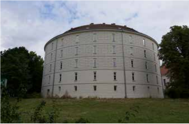
Der Narrenturm mit restaurierter Außenfassade.
